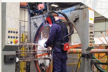
La fabrication d'armature
