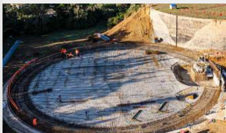
Réservoir d'eau potable Arles
