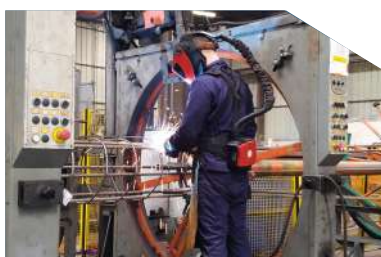
La fabrication d'armature
