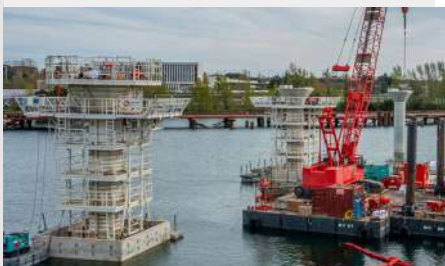
Réalisation de voussoirs de pont - Métro Toulouse connexion ligne B - 1500 Tonnes - Toulouse
